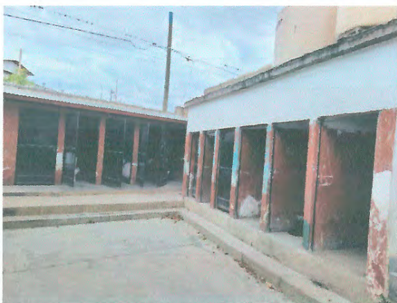
Foto 3: Mejoramiento de área de servicios sanitarios
