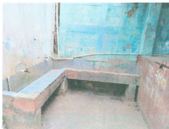
Foto 6: Mejoramiento de área de servicios sanitarios
