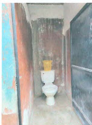
Foto 5: Mejoramiento de área de servicios sanitarios
