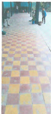
Foto 1: Mejoramiento instalación de piso
