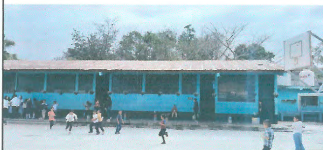
Foto 2: Mejoramiento cubierta de techo
